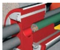
Fig. 10 - Atravessamento de lajes
